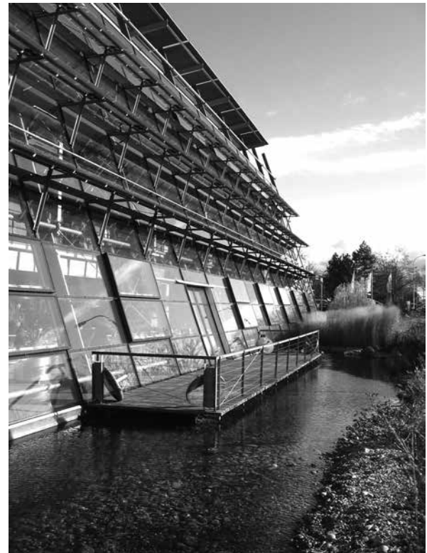
Bâtiment bioclimatique en Allemagne. Photo Marie Dariel.
