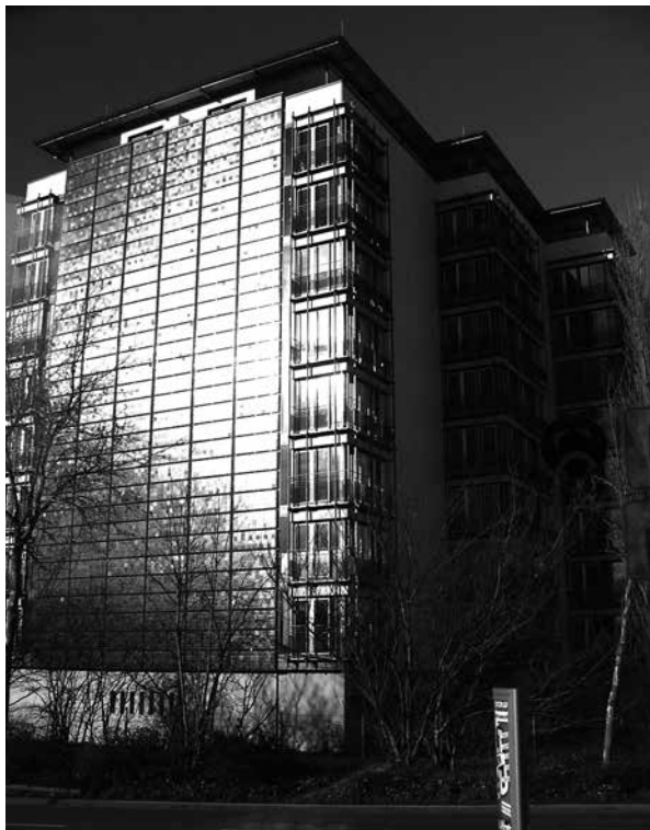
Fribourg en Allemagne. La façade sud de cet immeuble de logements datant des années 1960 a été rénovée et recouverte de panneaux solaires photovoltaïques. Photo : Marie Dariel, janvier 2008.
