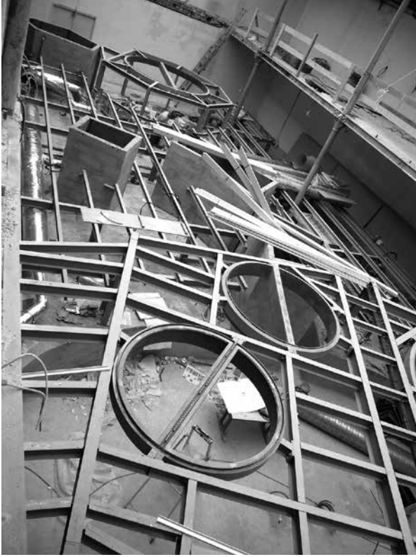
Bureaux des sociétés Pons et Huot, Stalingrad, Paris X ème (chantier).
